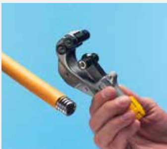
Rohr ablängen und Schutzisolierung entfernen.
