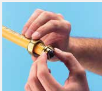
Mutter und Halbschalen einfügen.
